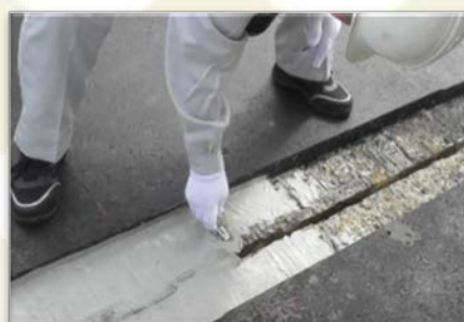
STEP5 敷き均し
