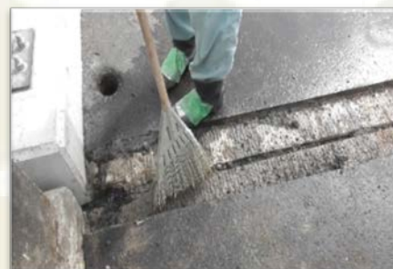
STEP2 施工面の清掃
