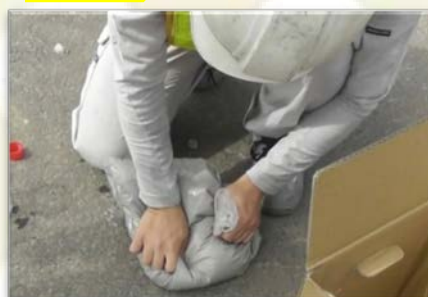
STEP3 材料の練り混ぜ
