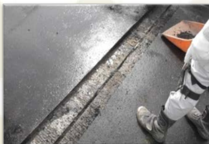
STEP1 施工前状況
