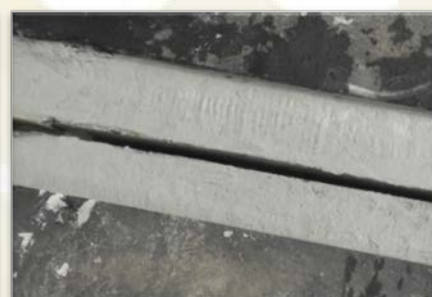
STEP6 施工完了
